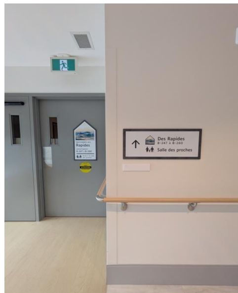
Signalisation directionnelle contrastée avec main courante, bandeau braille et capteur sans contact pour ouverture de porte.
