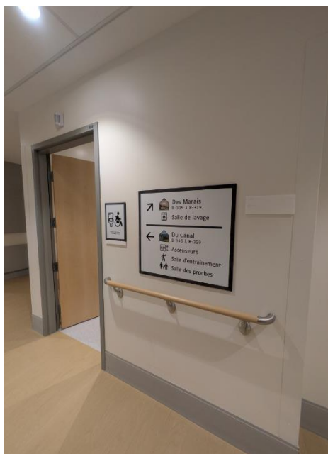
Signalisation directionnelle; présence de main courante continue et braille.
