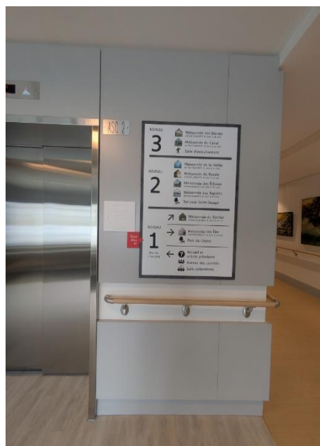
Signalisation directionnelle; présence de main courante continue et braille.
