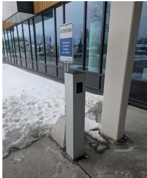
Portes automatiques avec capteur ouvrant vers l'extérieur et capteur extérieur sans contact à distance adéquate des portes pour libérer l'espace.
