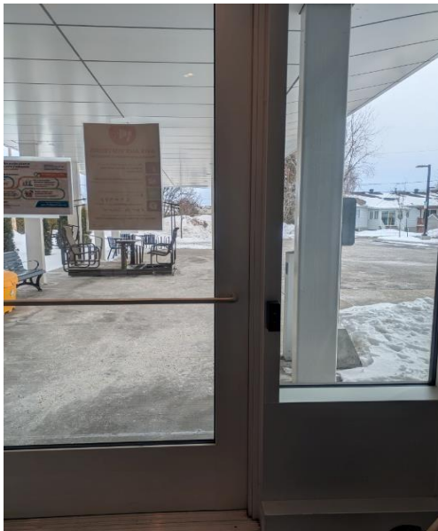
Portes automatiques avec capteur ouvrant vers l'extérieur et capteur extérieur sans contact à distance adéquate des portes pour libérer l'espace.
