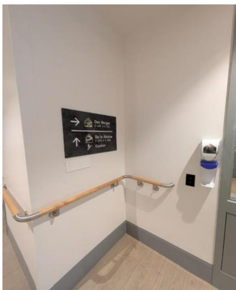
Signalisation directionnelle contrastée avec main courante, bandeau braille et capteur sans contact pour ouverture de porte.
