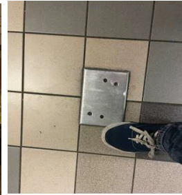
Corridor H121 fermeture de portes - plaques de métal à vérifier, nettoyer ou remplacer au besoin
